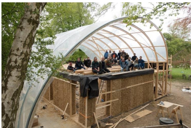
Højskolen Brøndrup lavede byggekurser, hvor alle kunne lære at bygge off grid bæredygtige huse. Og derfra eksempelvis gå ud og skabe bæredygtige lokalsamfund.
