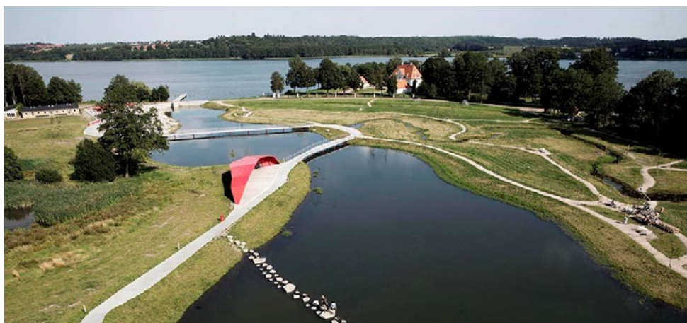
▲ Foto: Carsten Ingemann Klimatilpasningsprojekt ved Sønæs i Viborg, som både håndterer stigende mængder regnvand og samtidig skaber nye rammer for biodiversitet, kultur og naturoplevelser.
