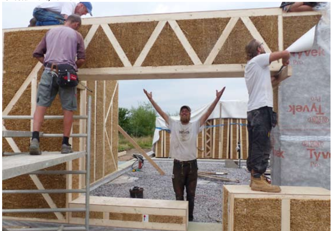
Et vinduesoverligger-kassette trækkes på plads, og vindspærren er ved at blive monteret til højre i billedet. Friland, Danmark.
